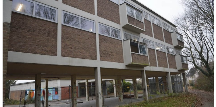
Zum Jahresende 2021 soll der Umbau, laut Schulplanerin abgeschlossen sein. Foto: Arlinghaus
